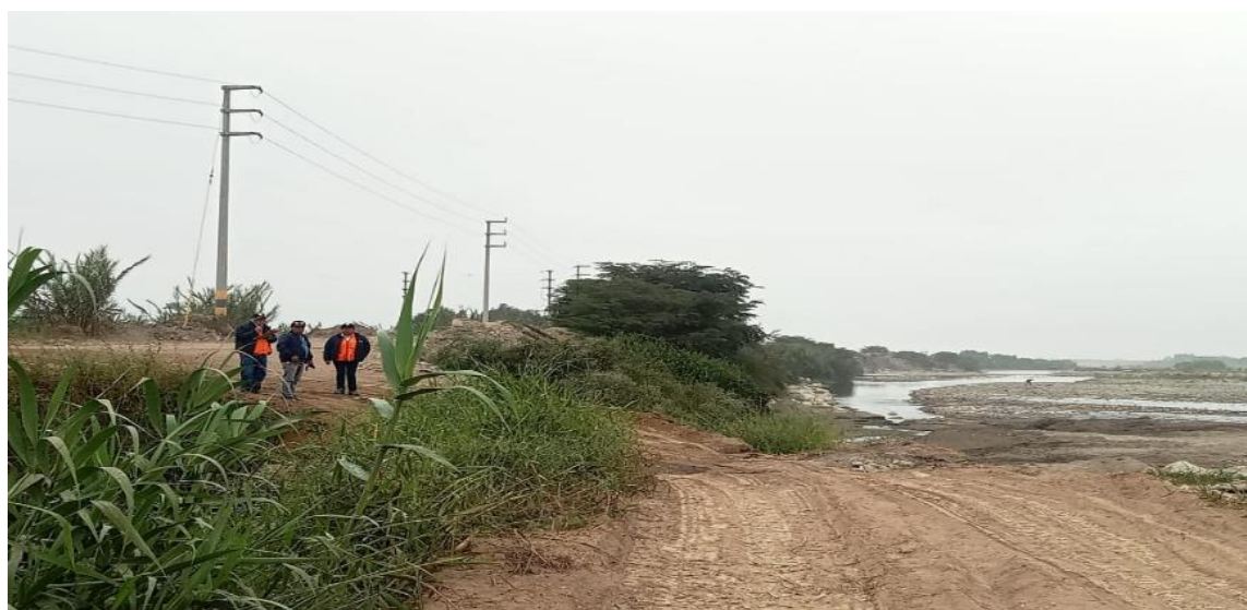
FIGURA N°02: MARGEN IZQUIERDA DEL RIO PISCO SECTOR CAPTACION FIGUEROA, SE ENCUENTRA SIN PROTECCION PONIENDO EN RIESGO LA CAPTACION FIGUEROA Y AREA AGRICOLA EN DICHO SECTOR.
